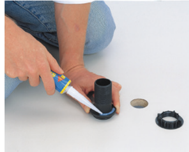
2. DEKAsyl MS-Kraftkleber auf den Stutzen der Dachdurchführung auftragen. Stutzen in die Bohrung einführen und von unten mit Rändelmutter fixieren.
